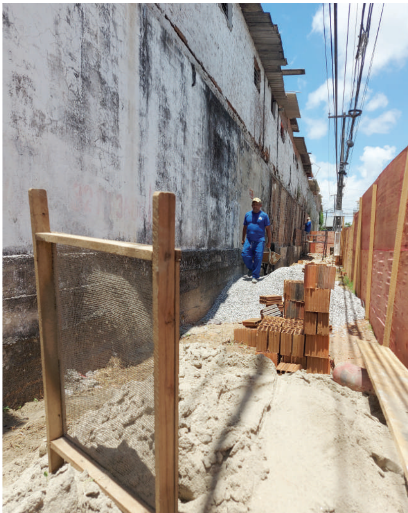
Reforma do Muro da Ceasa na Rua Potiguares
